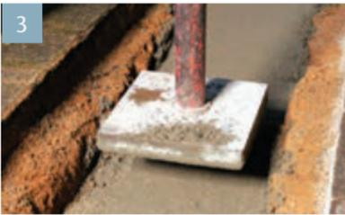
3 Den erdfuchten Magerbeton in den Graben füllen und verdichten. Berücksichtigen Sie ggf. die Höhe des Auslaufelements sowie den für die Fertigstellung erforderlichen Abstand von 3-5 mm zwischen Rostoberkante und Oberflächenbelag.
